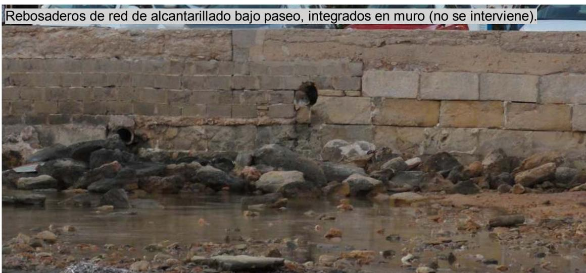
Rebosaderos de red de alcantarillado bajo paseo, integrados en muro (no se interviene).
