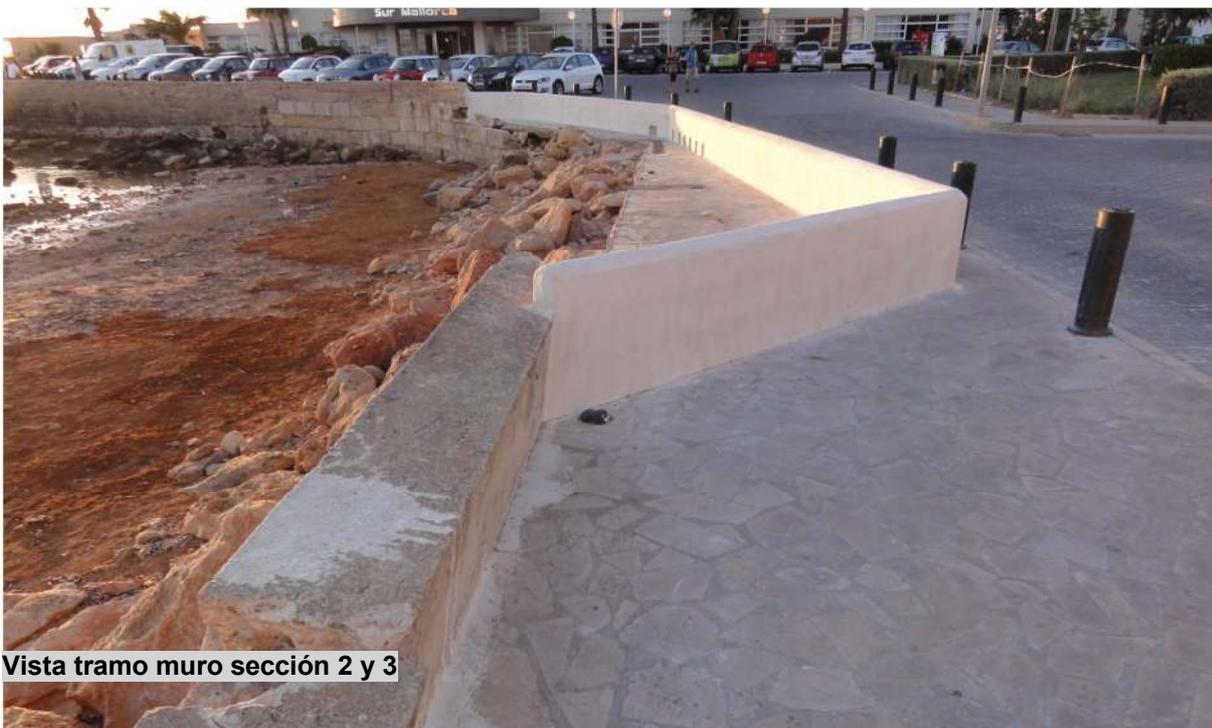
La intersección entre Calle Joan Miró y Paseo Romeo-Julieta presenta la cota más baja de calzada de todo el tramo de intervención, por ello es necesario dimensionar en el nuevo muro de contención embornales para la salida del agua acumulada. Puede observarse en el muro provisional la situación de embornales.
