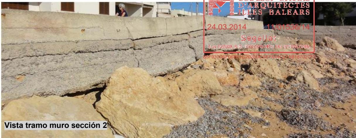
La cota del terreno rocoso queda por debajo de la base del muro de contención. Este vaciado se resuelve en proyecto situando la base de cimentación de muro por debajo del nivel ahora visible del terreno, y protegiendo el encuentro entre muro y terreno rocoso con un pequeño contrafuerte artificial similar al existente en fotografía anterior.
