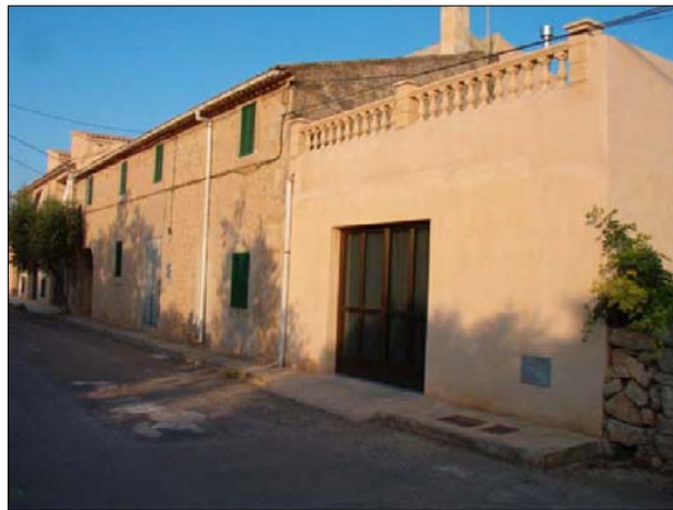
FAÇANA A CARRER DES TORRENT
