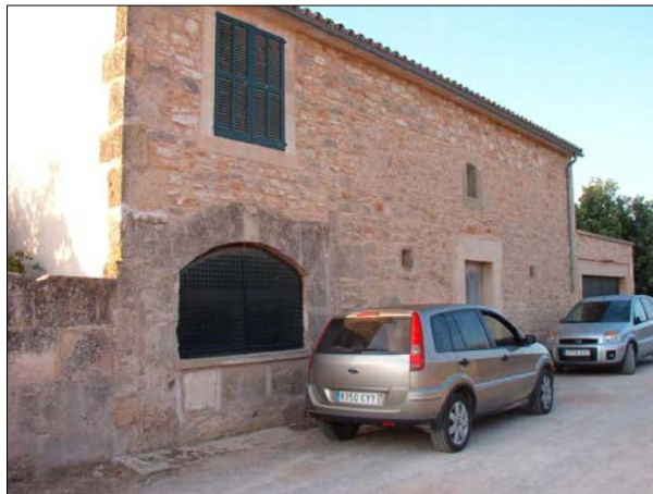
FAÇANA A CARRER
