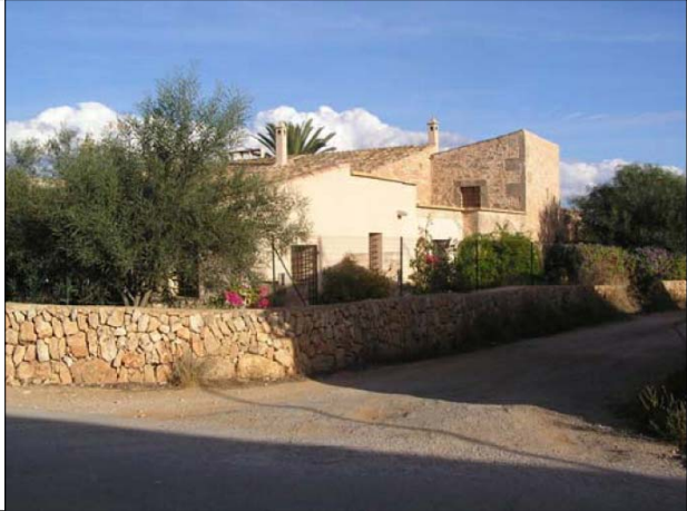
FAÇANA A CARRER
