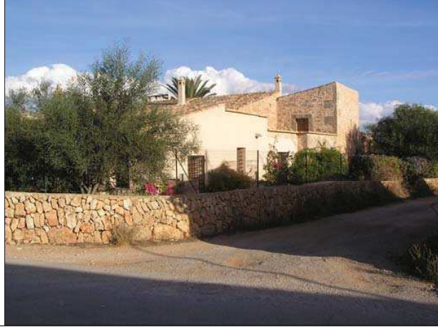
FAÇANA A CARRER
