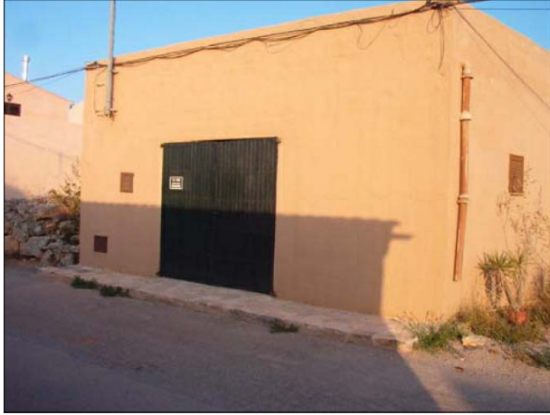
FAÇANA A CARRER DES TORRENT
