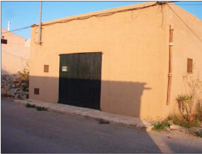
FAÇANA A CARRER DES TORRENT
