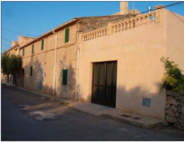
FAÇANA A CARRER DES TORRENT
