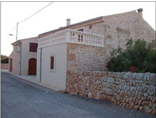
FAÇANA LATERAL DE L'ANEXA A L'HABITATGE PRINCIPAL
